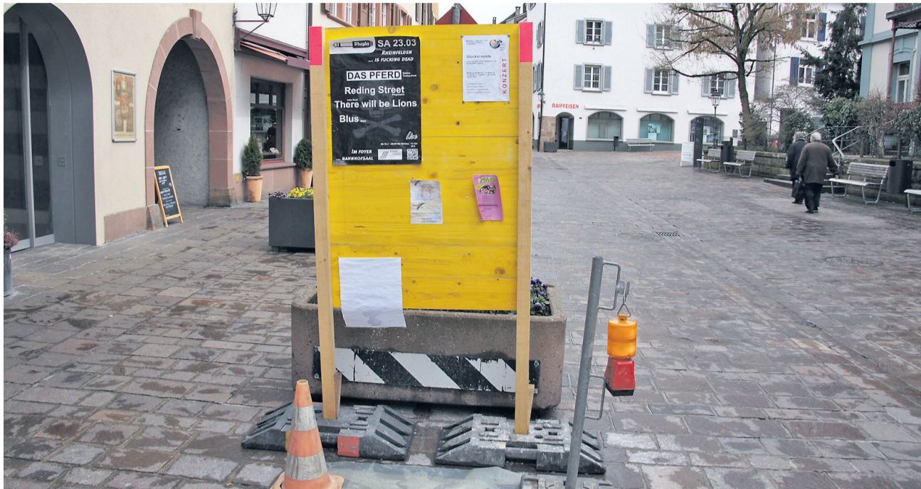
Die gelben Bretter dienen als Bauprofile für die umstrittenen neuen Plakatständer.
